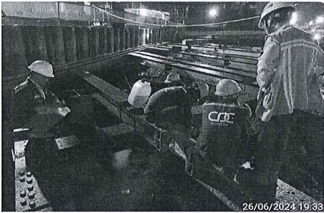
CÔNG TÁC KIỂM TRA COS, TỌA ĐỘ VÀ NỀN BÊ TÔNG
