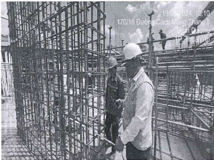
Nghiệm thu cốt thép vách V1H, V22
