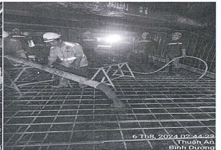
Đổ bê tông sàn hầm B2 đợt 2
