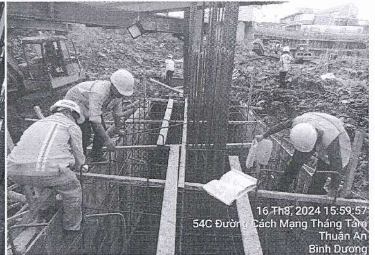
Nghiệm thu ván khuôn + cốt thép móng M2
