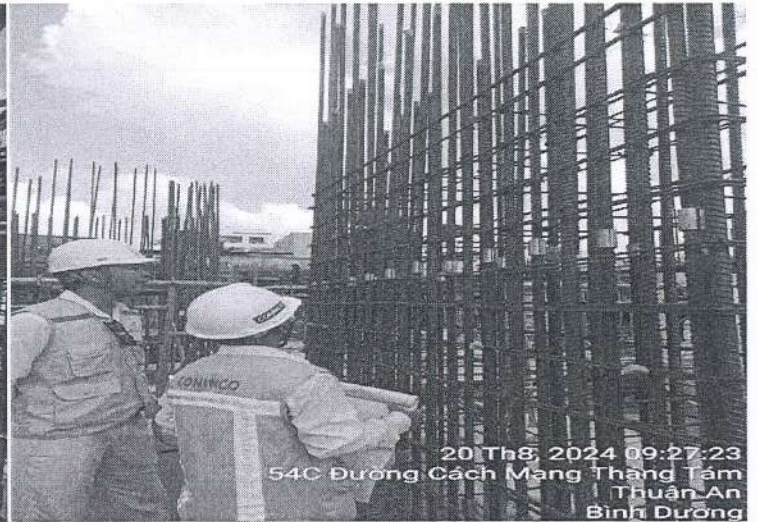
Nghiệm thu cốt thép vách V19, V16
