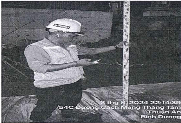
Nghiệm thu cao độ đất trước khi đổ bê tông lót sàn hầm B2
