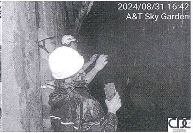
Nghiệm thu quét chống thấm vách tường hầm
