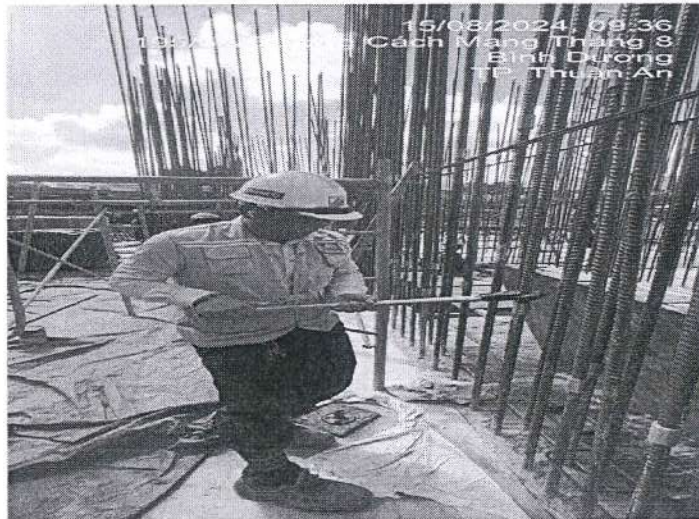
Nghiệm thu ty ren và siết lực coupler vách thang máy VTM1-A
