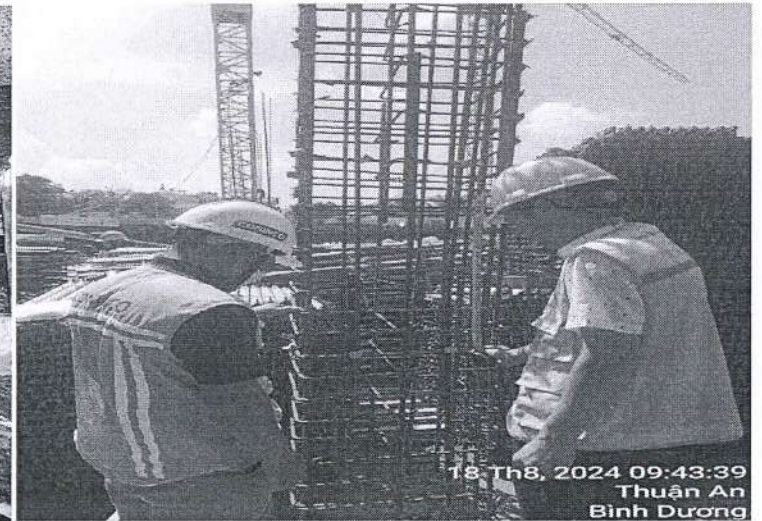
Nghiệm thu cốt thép vách thang máy, vách tường vẩy và cột C2+C4+C2B
