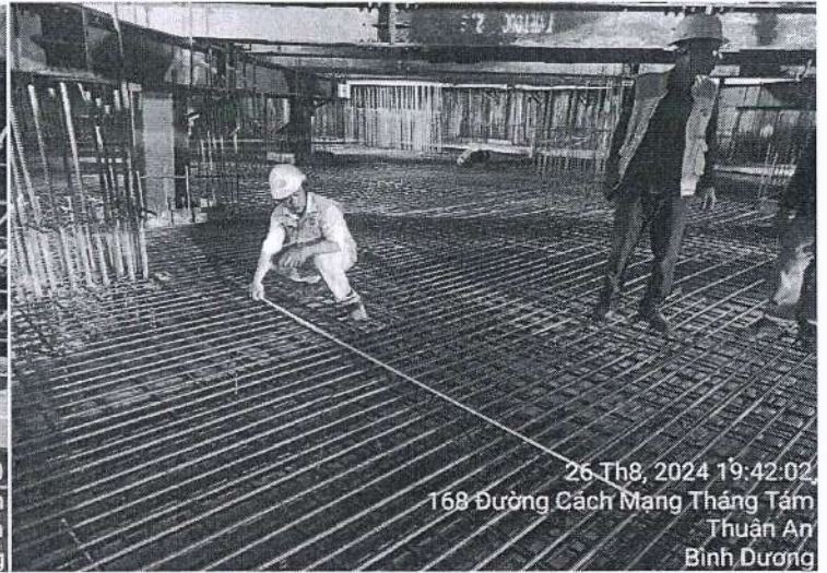
Nghiệm thu ván khuôn + cốt thép sàn hầm B2 đợt 5
