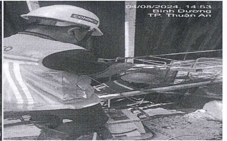
Kiểm tra khoan cấy thép dầm DCT5G
