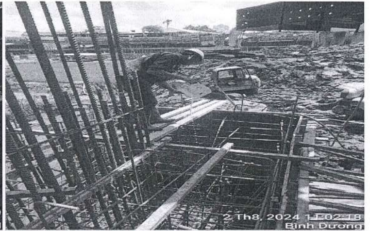
Tươi sika trước khi đổ bê tông móng M2D
