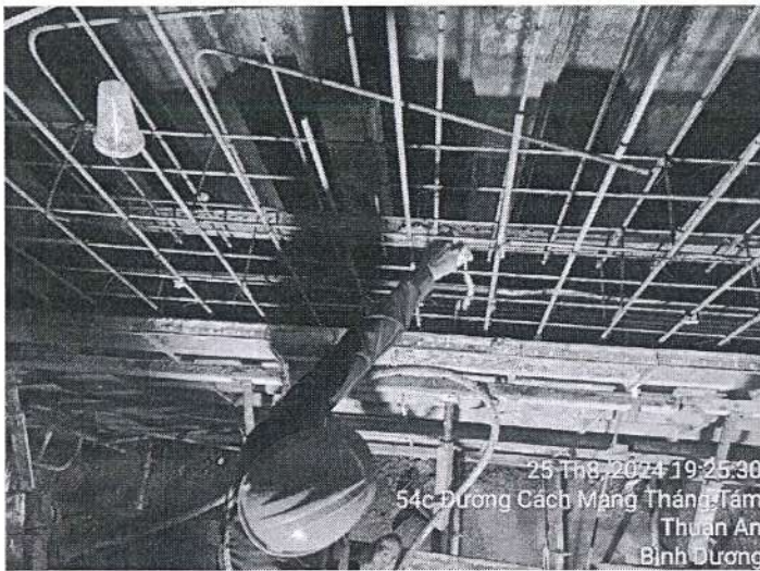
Tươi sika trước khi đổ bê tông vách tường vây hầm B2
