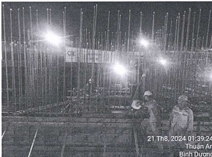
Tươi sika trước khi đổ bê tông vách thang máy VTM1
