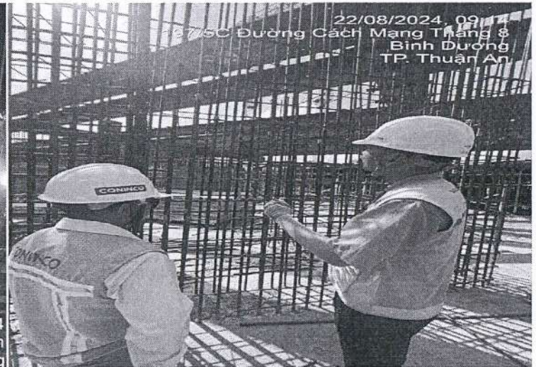
Nghiệm thu cốt thép vách V16, V18, V19, V21B, cột CDD (3 cột)
