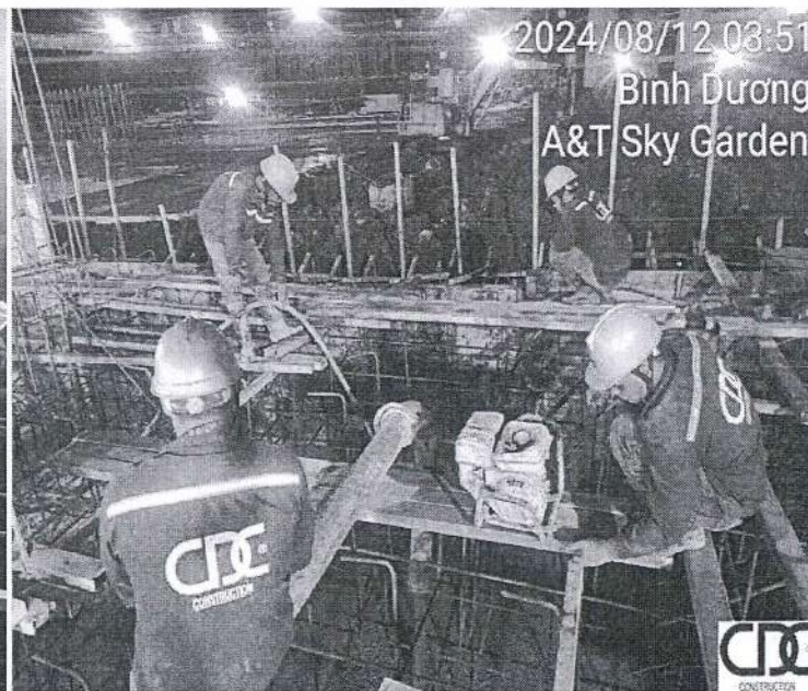
Đổ bê tông móng MTM1 (đợt 2)
