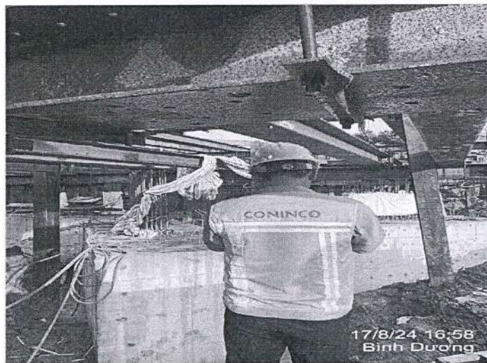
Kiểm tra xử lý ty móng M2
